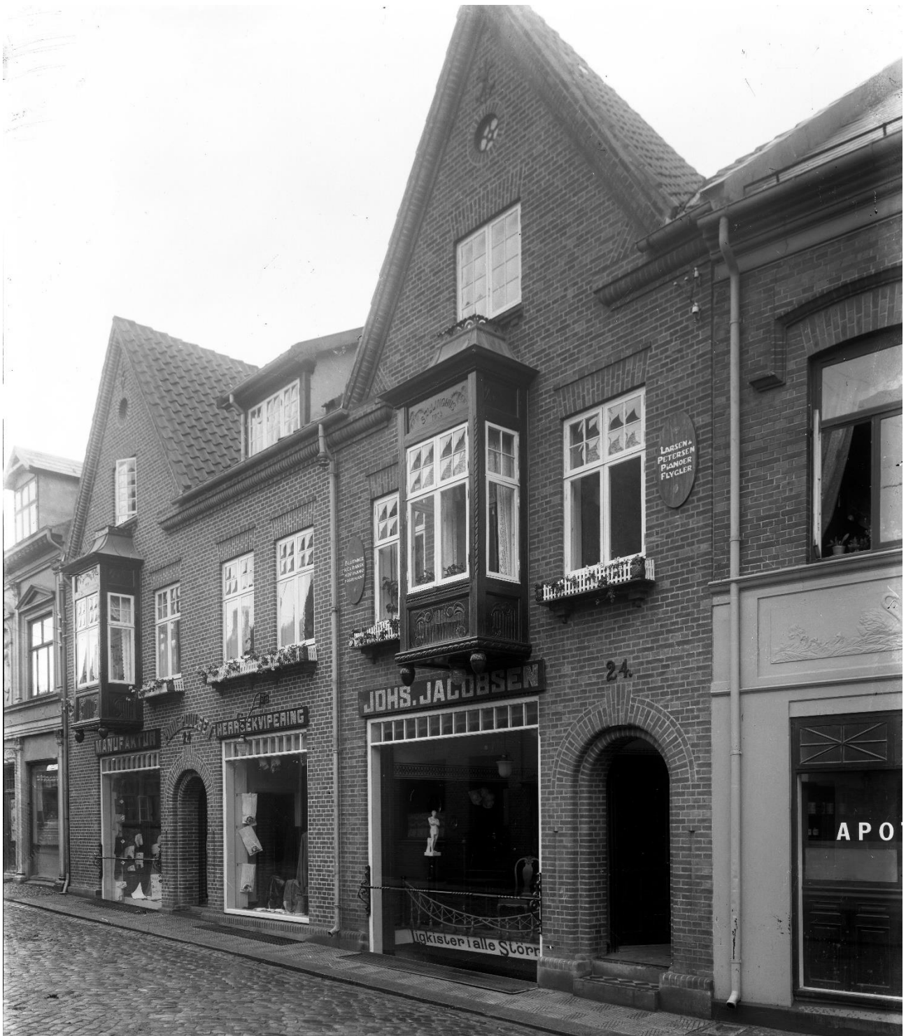
Tømrermester J.J. Vinkel arbejdede også som bygmester/arkitekter. Han tegnede flere landsbyskoler på Skiveegnen, og i Skive tegnede han bl.a. den store ejendom "Sallinghus", Nørregade 24, med de to markante karnapper. Ejendommen blev opført i to etaper i 1917 og 1919.
